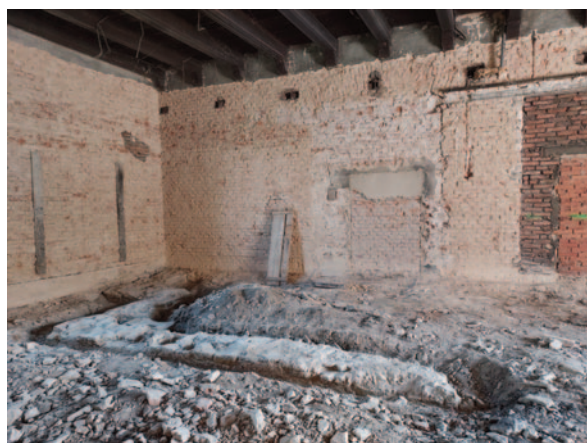
Obr. 46. Lysá nad Labem, okr. Nymburk. Pohled na SZ roh bývalé garáže. V podlaze je patrný druhý odkrytý úsek ohradní zdi areálu kostela Panny Marie.
