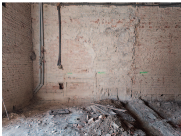
Obr. 45. Lysá nad Labem, okr. Nymburk. Pohled na jižní stěnu rekonstruované místnosti. Na snímku je patrné SZ nároží jižního křídla bývalého konventu, zazděné okno se sklepním světlíkem a také v podlaze odkrytý relikt původní ohradní zdi.
