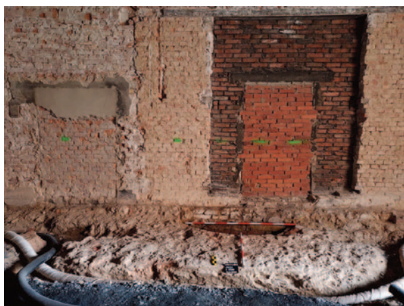
Obr. 47. Lysá nad Labem, okr. Nymburk. Dokumentovaná část jižního schodišťového rizalitu zaniklého kostela Panny Marie.
