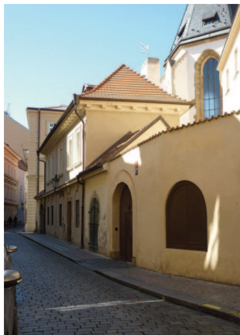
Obr. 13. Dům v Liliové ul. 951/5 na Starém Městě v Praze, kde sídlil VGDB od roku 1893 (foto autor 2024).
