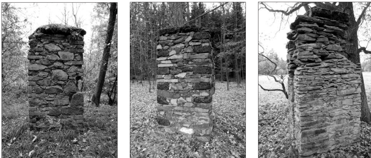
Obr. 5. Obora Králova stolice. Detaily jednotlivých sloupků ohrazení obory Králova stolice u Dobříše (východní část). Fotografie ukazují nejrůznější typy používaných materiálů pro vyzdívání sloupků. Foto autor
