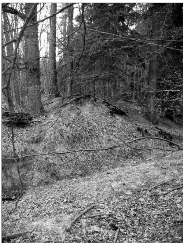
Obr. 15. Pohled na strženou propust Malého komárovského rybníka od východu (2007)
