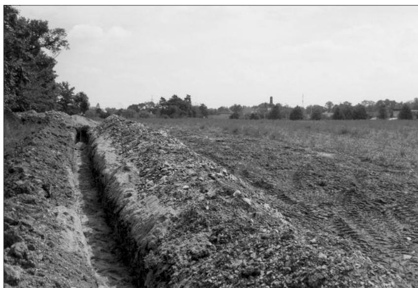
Obr. 23. Vodovod Dolní Břežany–Lhota. Nahoře: pohled směrem k západu na velkou část pramenné pánve a trasu stavební rýhy. Dole: východní část pramenné pánve v místech s halštatskými objekty. V pozadí věž zámku v Dolních Břežanech
