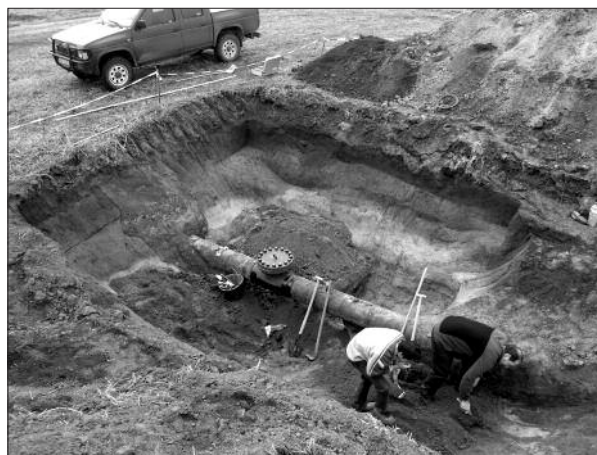
Obr. 4. Kolín-Štářalka. Celkový pohled na sondu výzkumu
