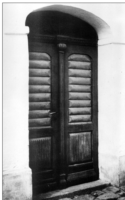
Obr. 23. Vrátníkové náplně z archaických pažnic. Horní náplně dveřních křídel provedeny z ležatých oblých pažnic vpažených v těsném sponu do draží bočnic. Bývalé domovní dveře v Poličce, Pálená ulice čp. 137 (Líbal, D. – Junek, D. – Kopřiva, J. – Holomý, Z. – Hájek, J.: Klasicistní domovní vrata v Poličce . Polička 1994, s. 32)
