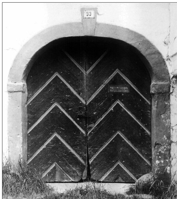
Obr. 41. Vrata se zalamovanou pásovou bosází. Vrátně s opeřením v klasovém sponu; pera se specifickou profilací hran reprezentují charakteristickou architektonickou figuru zalamované pásové bosáže; hrany kontrastně kolorovány. Vrata zemědělské usedlosti čp. 33 v Sádce u Poličky, z doby mezi léty 1756–1758. Výřez reprodukce (Junek, D.: Dveře a vrata na Poličsku v 19. století. Polička 1998, s. 55)
