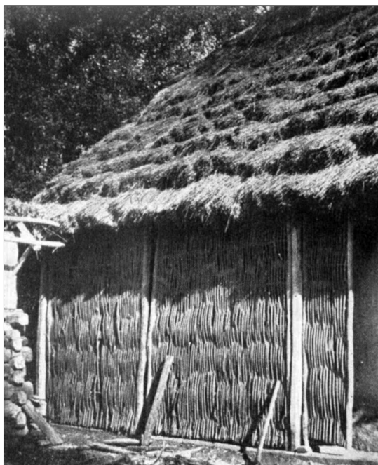
Obr. 5. Vrata žebřinové soustavy. Archaická tesařská žebřinová soustava s výpletem. Vrata stodoly v Ruském Hrabovci (MencI, V.: Lidová architektura v Československu. Praha 1980, s. 19, obr. 24)
