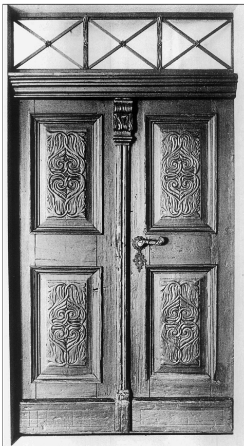
Obr. 45. Aplikace příklopky a okopnice. Na veřeji s kasetami aplikována příklopka formy pilastru s autonomní patkou a hlavici, vynášející římsu aplikovanou na poutci zárubně, a okopnice formy podnože s ilusivní řezbářskou fakturou kostek. Dveře hostince čp. 178 ve Stašově u Poličky. Výřez reprodukce (Junek, D.: Dveře a vrata na Poličsku v 19. století. Polička 1998, s. 57)
