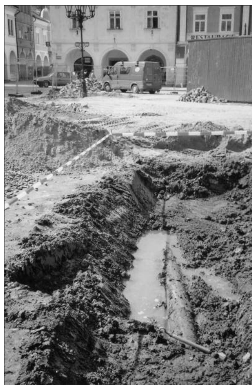
Obr. 5. Jičín, Valdštejnovo náměstí 2009. Vodovod k jihozápadnímu okraji náměstí
