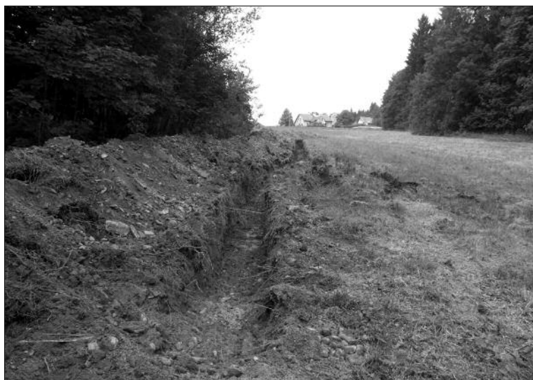
Obr. 3. Dolní Černá Studnice, k. ú. Jistebsko. Zjišťovací sonda. Pohled od jihu
