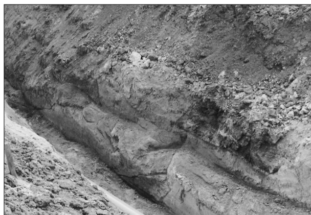
Obr. 5. Radim, „Na Černé“, rýha vodovodu, objekt 7. Vnitřní okraj příkopu s částí profilu V1–Z1 (foto M. Vávra)
