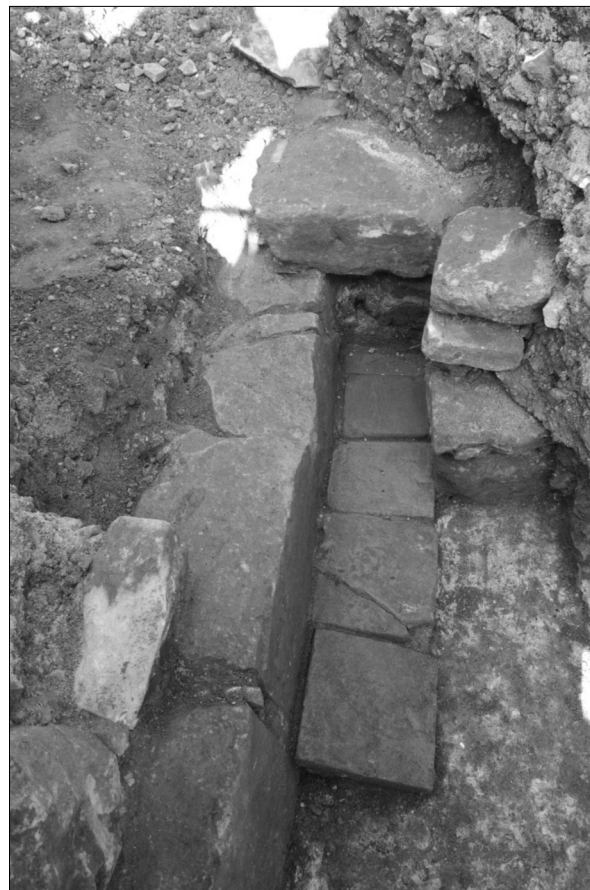
Obr. 3. Brandýs nad Labem, okr. Praha-východ. Část starší kanalizační stoky narušené v prostoru původního barokního opevnění
