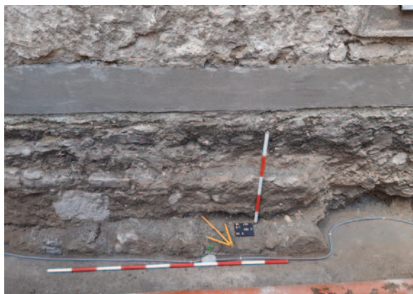
Obr. 43. Svatý Jan pod Skalou. Základové zdivo pod kostelní věží.
