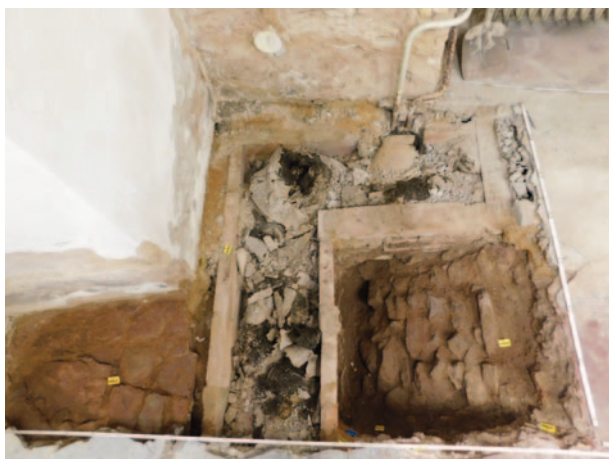
Obr. 24. Český Brod, č. p. 1. Sonda 10. Vpravo rub klenby gotického sklepa (zeď 10903), vlevo základ obvodového zdiva (zeď 10902). Situace je narušena recentním topným kanálem (zeď 10901). Pohled od jihu. Foto autor.
