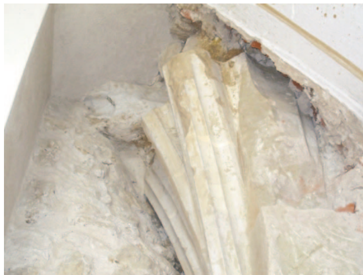
Obr. 7. Bělá pod Bezdězem. Detail výběhu trojice žeber na stěně mezi Černou kaplí a sakristií. Foto J. Koutová.
