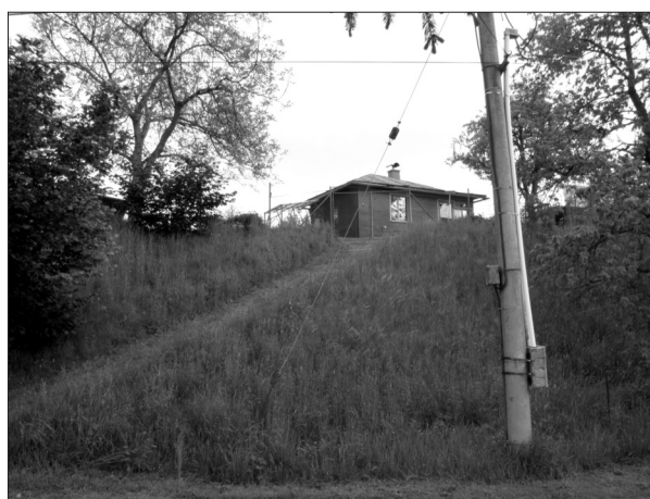
Obr. 3. Turnov-Nudvojovice. Pohled od jihu na chatu čp. 12. Jde o typickou sídlištní polohu nad terasou Jizery. Foto J. Prostředník
