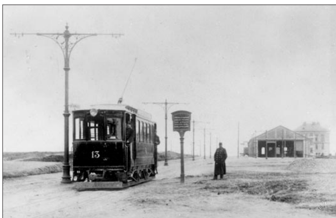
Obr. 6. Archivní snímek zčásti postavené vozovny Vinohrady, druhá polovina roku 1897. Zdroj: Archiv dopravního podniku Praha.
