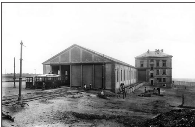
Obr. 5. Archivní snímek zčásti postavené vozovny Vinohrady, druhá polovina roku 1897. Zdroj: Archiv dopravního podniku Praha.
