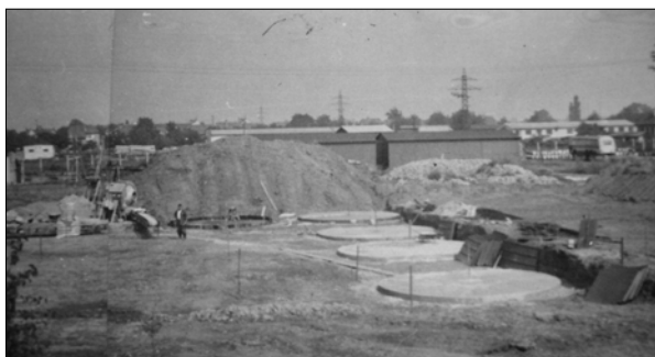
Obr. 12. Výkop se základy nádrží na olej v průběhu výstavby (foto V. Fencel 1968)
