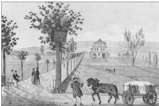
Obr. 11. Pohled z hlavní silnice na alej vedoucí k obci Bylany. V pozadí lázeňský dům a jednotlivé zastřešené studny na jímání minerálních vod v jeho okolí (2. polovina 19. století)
