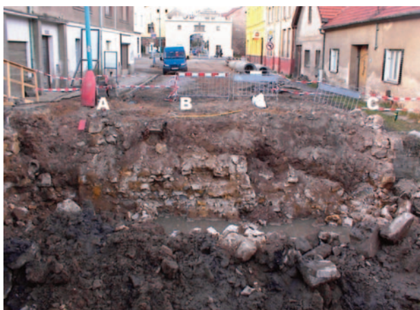
Obr. 14. Český Brod, ulice Prokopa Velikého, severní strana mostu přes Šemberu po odbagrování. Popis jednotlivých zdí (A, B, C) v textu. Pohled od jihu. Foto M. Křemen, upravil autor.
