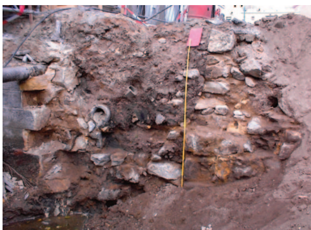
Obr. 15. Český Brod, ulice Prokopa Velikého, severní strana mostu přes Šemberu po odbagrování. Detail západního líce zdiva zaniklého mostu (zed' A na obr. 14). Pohled od jihu. Foto M. Křemen.
