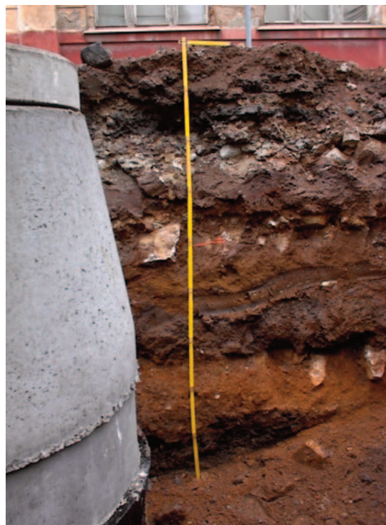
Obr. 7. Český Brod, ulice Prokopa Velikého. Hlavní řad vodovodu a kanalizace před č. p. 105. Patrné tři úrovně kamených dlažeb komunikace. Pohled od západu. Foto M. Křemen.
