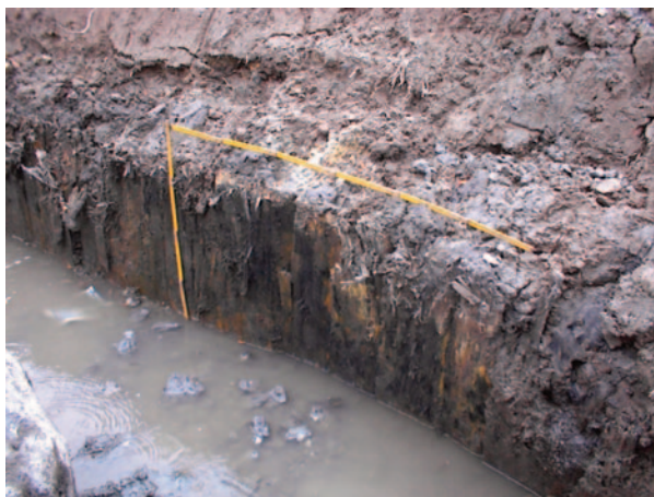
Obr. 17. Český Brod, ulice Prokopa Velikého, jižní břeh Šembery po odstranění současného mostu. Nedatovaná dřevěná stěna z prken. Pohled od severozápadu. Foto M. Křemen.
