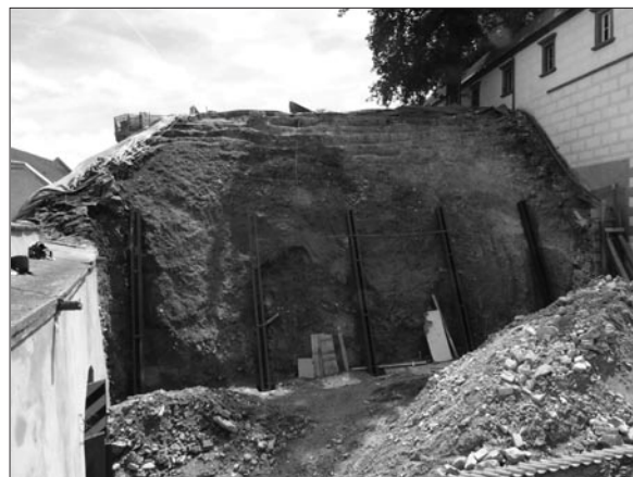
Obr. 1. Brandýs nad Labem. Zajištění statiky barokního bastionu v místě sesunuté kamenné plenty
