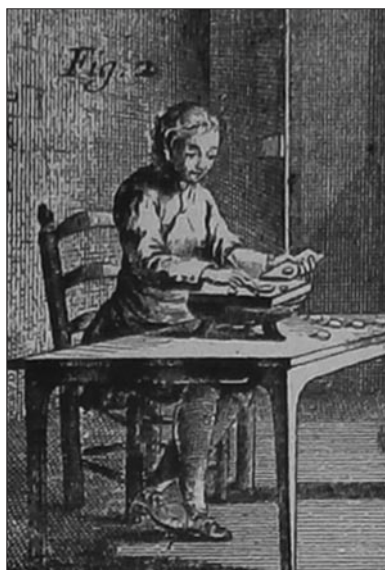
Obr. 4. Při výrobě lisovaných knoflíků se jako lepidlo používala rozehřátá pryskyřice. Podle Diderot 1772, 79, pl. III
