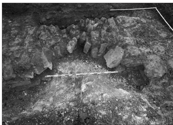
Obr. 6. Mšecké Žehrovice. Západní obslužný otvor, detail zaklenutí, v popředí nevybraná poslední vsázka vypáleného vápna. Pohled od severu
