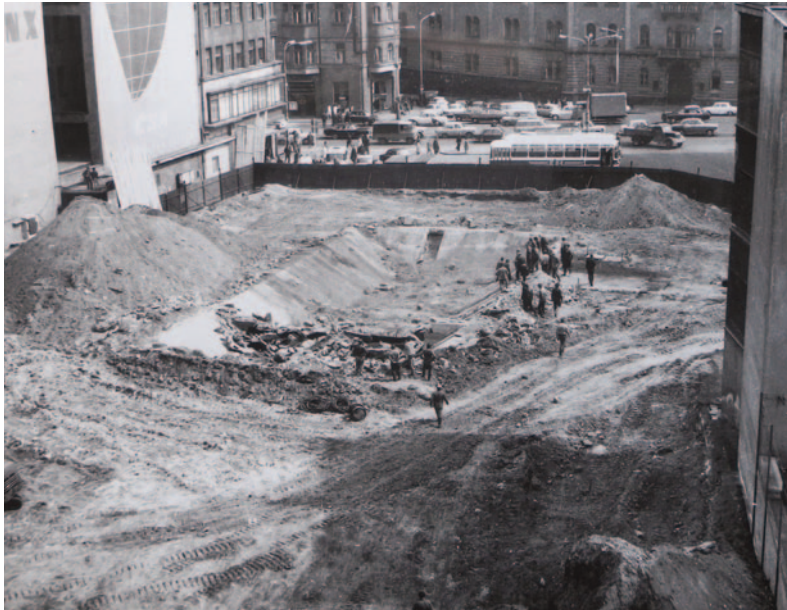
Obr. 2. Praha – Staré Město, Kotva. Pohled na část plochy výzkumu od západu. Zdržení prací způsobila i komplikovaná likvidace válečného protipožárního bazénu. Hromada vlevo nebyla odvezena včas a výzkum na jejím místě už nemohl proběhnout. Foto Zd. Helfert 1971, archiv NPÚ Praha.
