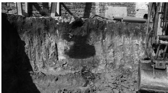
Obr. 1. Brandýs nad Labem. Objekt v profilu stavební jámy.
