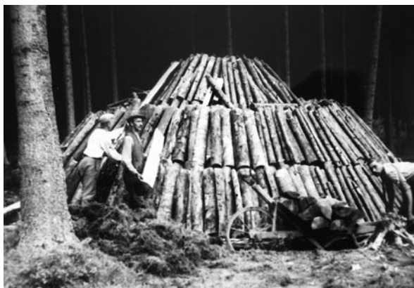
Obr. 18. Skládání milíře na polesí Svatá Dobrotivá – Kvaň. Fotografie na obr. 18–20 byly pořízeny mezi lety 1921 a 1928. Soukromý archiv Lud'ka Hůlky.
