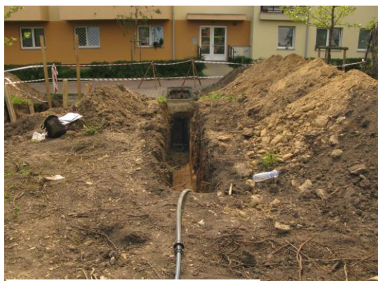
Obr. 1. Celkový pohled na výkop 1.
