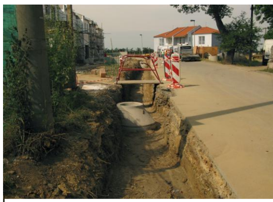
Obr. 1. Celkový pohled na jeden z výkopů pro inženýrské sítě.
