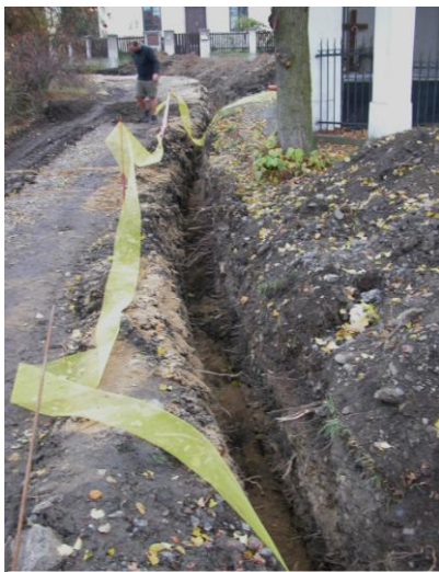
Obr. 1. Pohled na jeden z výkopů v prostoru u kapličky.
