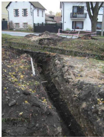
Obr. 2. Pohled na další část výkopu v prostoru u kapličky.
